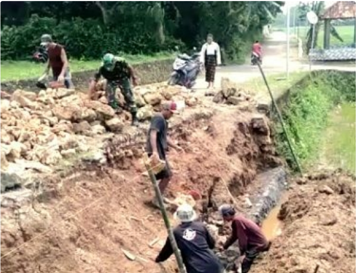
Karya Bakti pembuatan plengsengan penahan jalan
